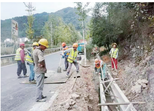
开化 ▲10月12日,在油古线7K+600路段,开化县公路港航与运输管理中心养护人员正在忙着浇筑水沟,确保山区公路排水顺畅。 □徐曙光
