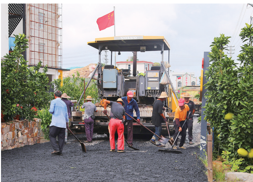
玉环 ▲10月10日,玉环市清港镇垟根村对村道进行“白改黑”提升改造。图为工人们在原混凝土路面上铺设沥青。 □吴达夫 李金春
