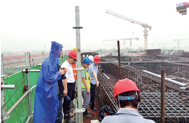
质量监督工程师在检查工地。
