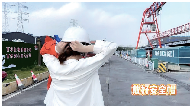
记者戴好安全帽准备进入施工现场。
