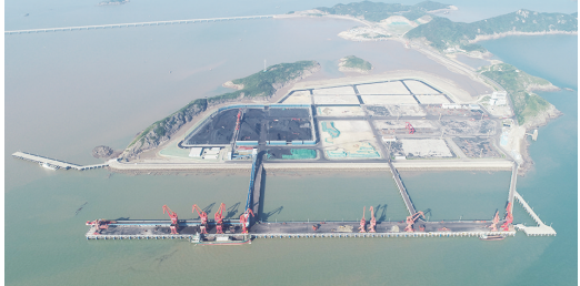
▲日前,台州港头门港区二期工程(陆域)通过交工验收。 □史册 卢将华
