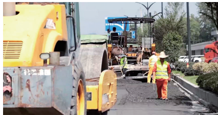
S305省道（富衢线）大中修
