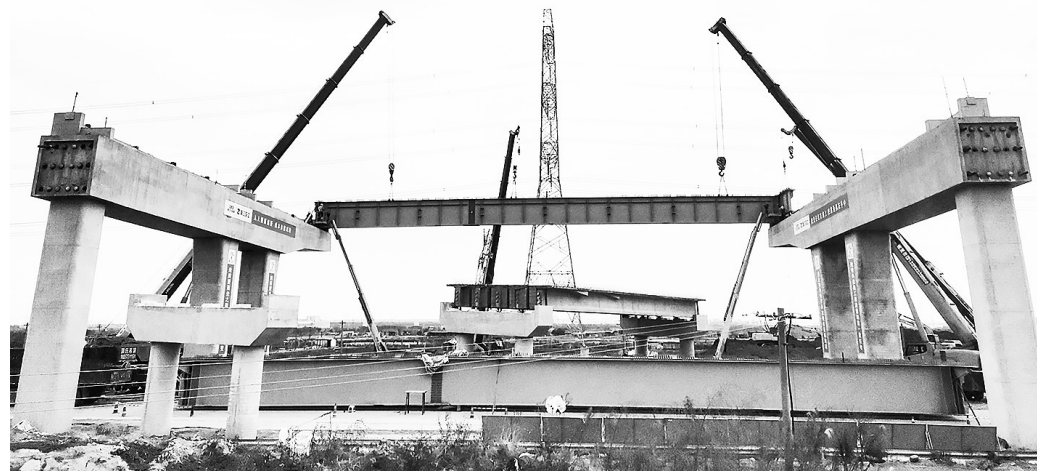
马鞍互通主线桥首片钢板梁架设现场。罗密/摄
