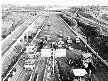
施工队伍正在进行沥青摊铺。黄小羽/摄
