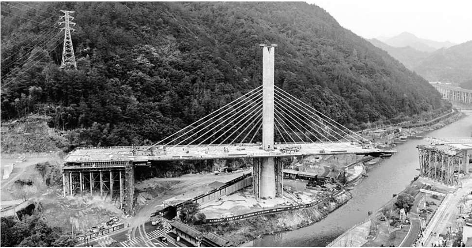
建设中的景宁高架桥。许瀚文/摄
