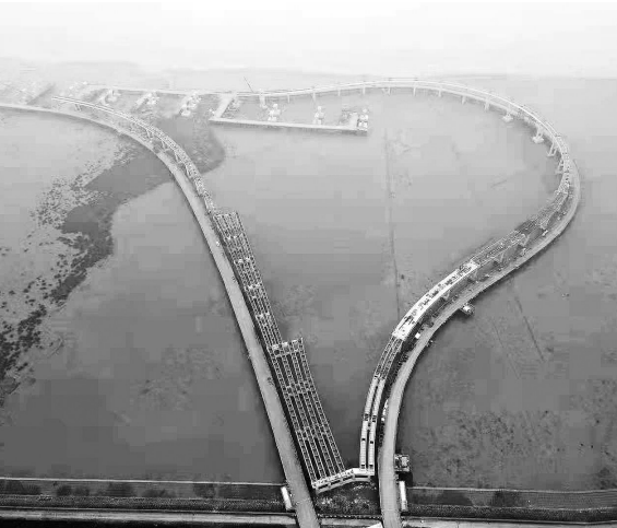
威海互通桥梁俯视图。于景德/摄
