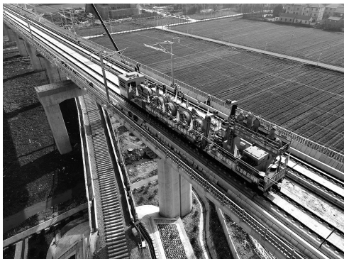
湖杭铁路接触导线架设现场。庄宝义/摄
