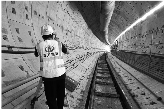
杭州地铁3号线一期工程施工现场。张在钱/摄
