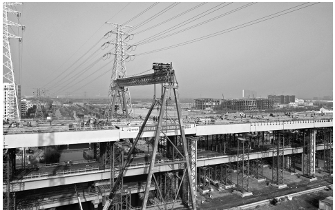
钢箱梁吊装现场。韩潇/摄
