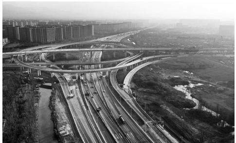
三墩互通改建工程建设现场。吴力/摄
