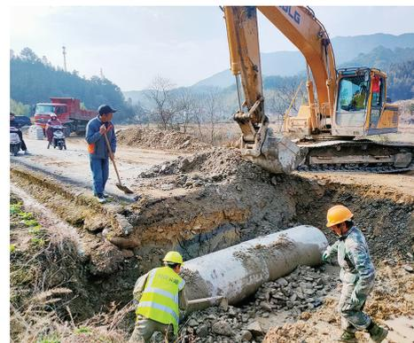
**开化** ▲1月13日,开化县池淮公路站养护人员在县道公路转大线16K+720路段埋设涵管,确保涵洞排水顺畅。
