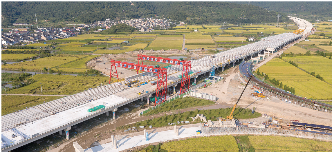
1月17日,象山湾疏港高速TJ-3标T梁架设现场。廖文柳/摄
