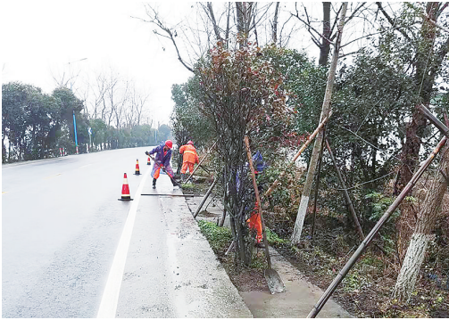
路桥 ▲日前,为全面改善公路路侧环境,台州市路桥区公路与运输管理中心开展“两路两侧”专项整治行动,组织养护人员对辖区内主要公路进行养护,集中对地下排水沟进行修复、对路面排水孔、桥梁下水孔进行疏通,保障雨天公路排水系统畅通。 □郑菲菲
