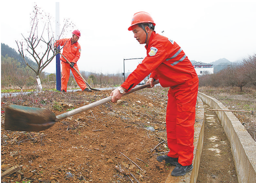
开化 ▲1月25日,衢州市开化县池淮公路站站长余坚(右)正带领工友们在县道篁竹线中村路段清理边坡,美化公路,为春运营造安全整洁的路域环境。 □徐曙光 余士平
