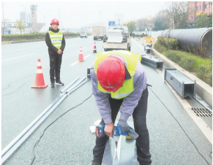
金华市区环城西路施工现场。厉俊俏/摄
