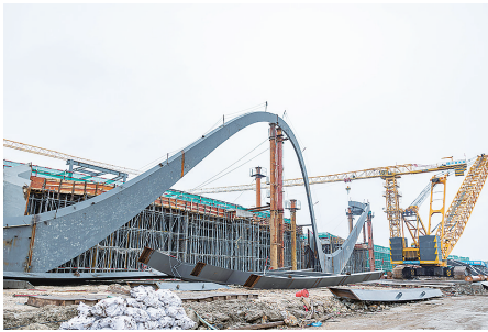
施工中的台州机场改扩建项目航站楼。
