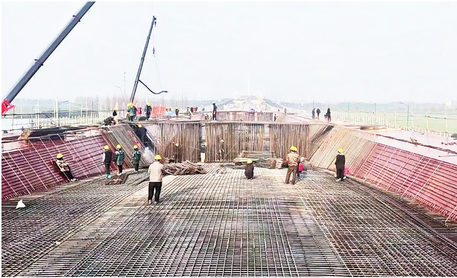
施工现场。钱塘区重大交通项目办供图
