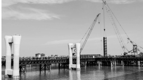
现场正在通过履带吊安装钢护筒。
