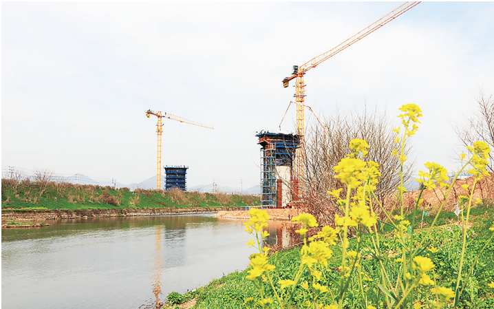
杭温铁路二期浦江段施工现场。高天峰/摄
