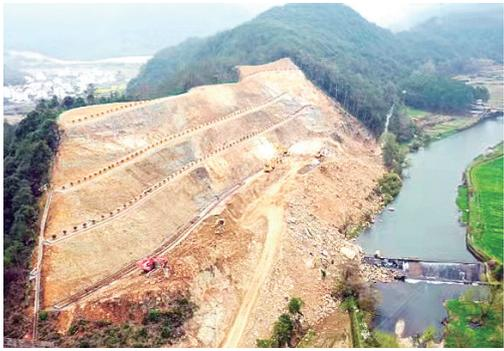
**浦江** ▲去年5月,浦江县大畈乡夏黄村南侧山体大面积崩塌,造成该县县道黄大线道路中断。随后浦江县交通集团对崩塌现场开展全面治理。目前,治理工程已近尾声,道路即将恢复通车。
