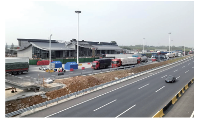
施工现场。项早伟/摄
