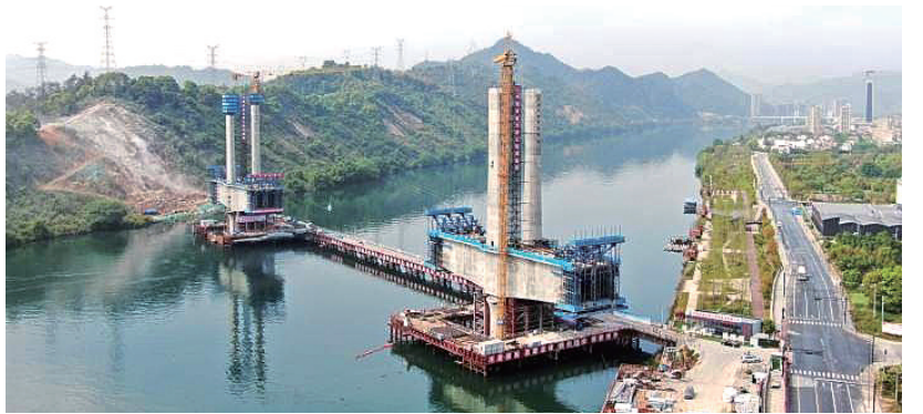
施工现场。方祺/摄
