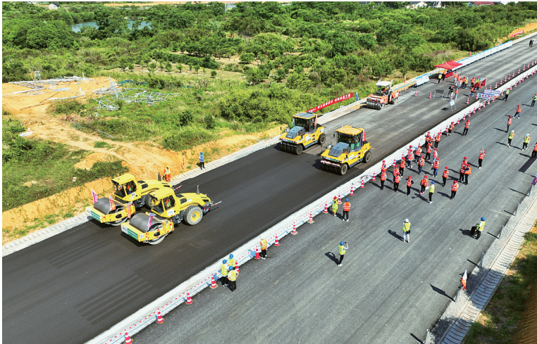
施工现场。黄小羽/摄
