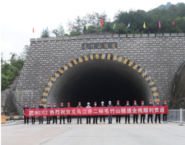
隧道贯通现场。
