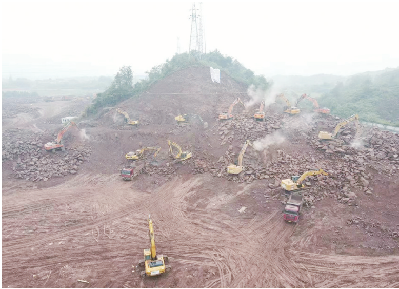
施工现场。项早伟/摄
