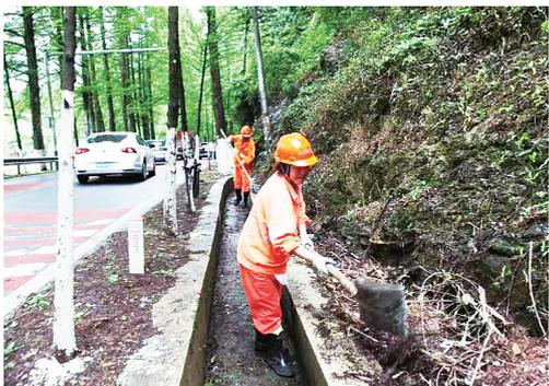
**开化** ▲近日,开化县公路港航与运输管理中心的养护人员在桃下线星口路段清理边沟,确保边沟排水顺畅、公路安全畅通。
