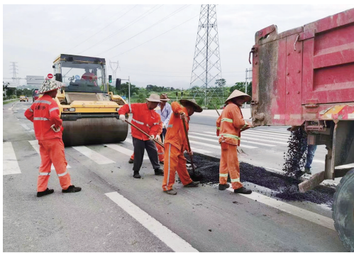
天台 ▲5月26日,天台县交通运输局普法人员走访辖区重点运输企业,向企业负责人、运输驾驶员们宣传了“爱路、护路”知识。同日,天台县公路与运输管理中心也组织人员,对路面病害进行治理修复,以消除安全隐患。 □朱梦华 许淑娥 张诗雨
