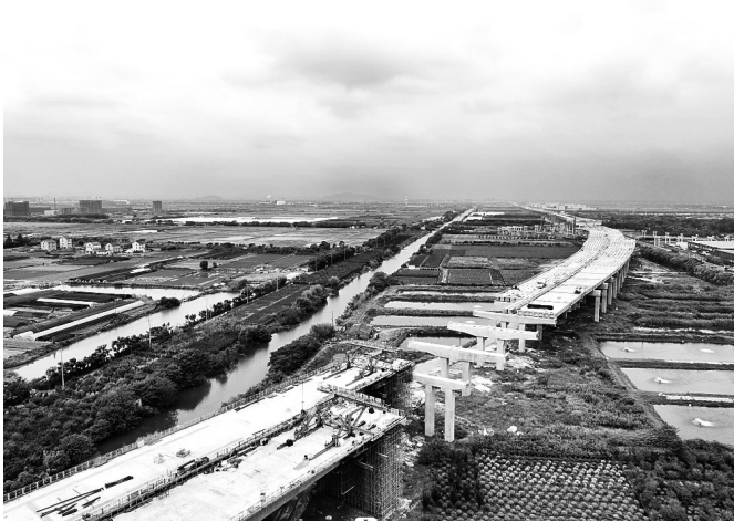
施工现场。洪晓龙/摄
