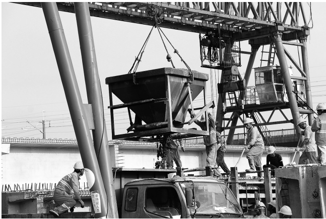
T梁预制现场。雷桥/摄
