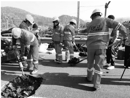
养护现场。郭飘飘/摄
