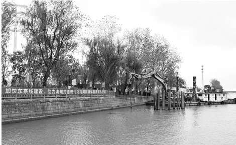
施工现场。管宇豪/摄
