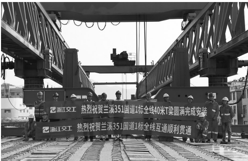
T梁安装现场。张成玉/摄
