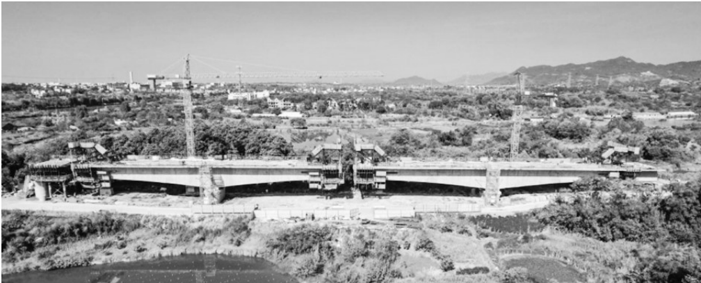
浇筑现场。徐金洪/摄
