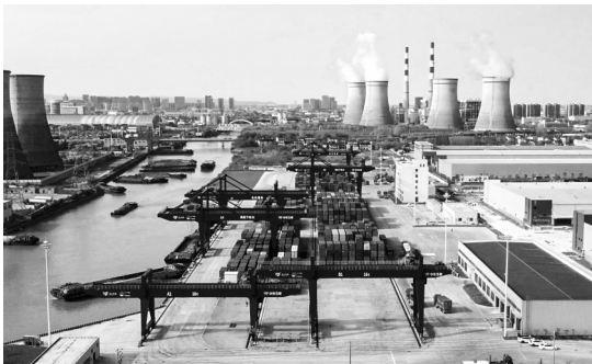
长兴县铁公水多式联运中心集装箱码头作业区一景。湖州港航供图
