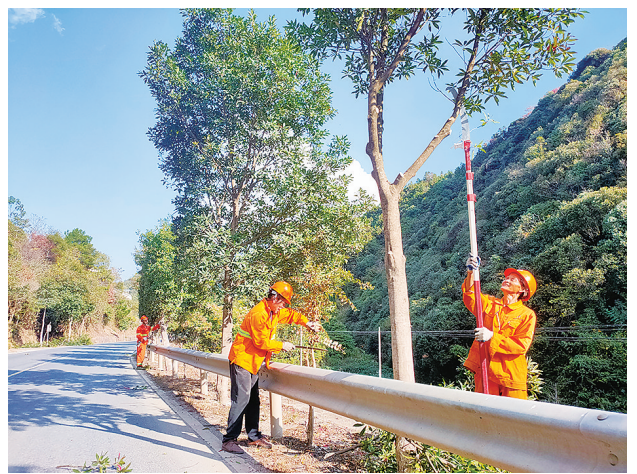
开化 ▲近日,开化县池淮公路站组织养护人员在该县城白线36k+700路段,对有碍行车视线的行道树枝进行修剪,以打造视觉良好,景色优美的生态公路景观大道。 □徐曙光 余坚
