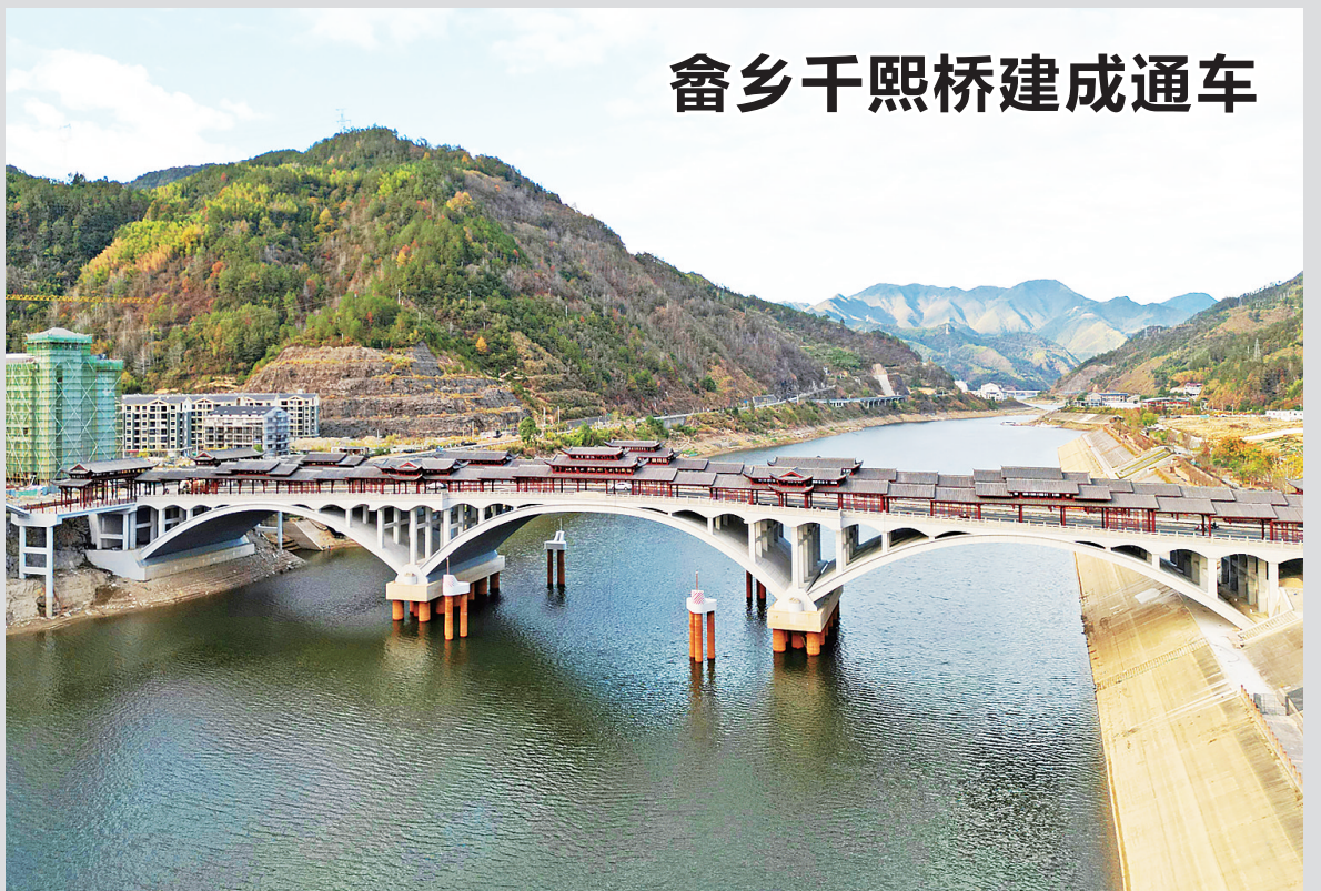
景宁 ▲日前,景宁千熙桥正式启动试通行。该桥横跨千峡湖两岸,西侧与G235国道相联接,东侧与千湖路和畚乡古城规划路相连。桥体总长242米、宽32米,采用三跨上承式钢筋混凝土连续拱桥结构。 □陈爱民
