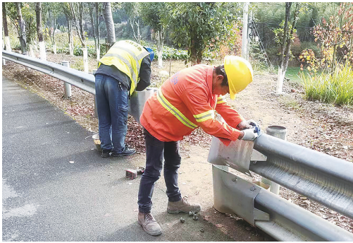
开化 ▲11月20日,开化县公路部门组织养护人员在该县齐溪镇西莲线上补全钢质波型护栏上缺失的端头,筑牢安全防线。 □徐曙光 周静
