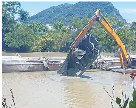
路桥 ▲近日,台州市路桥区港航事业发展中心开展内河航道清理整治行动,对区内栅温线、七条航线内的沉船、残留老桥墩进行了清除。 □林斌
