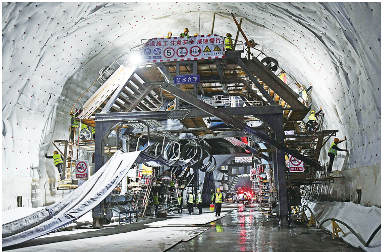
仙居 ▲11月18日,杭温铁路仙居隧道出口至斜井段顺利贯通,为下一步隧道全线贯通奠定了坚实基础。仙居隧道是杭温铁路全线重点控制性工程,全长8228.91米,分为进口、出口及斜井3个作业面组织施工,其中斜井至出口段3216米。 □王华斌 孙伟
