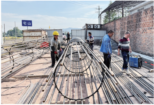
武义 ▲连日来,武义县2022农村公路病旧桥梁维修改造工程(一期)项目加速推进。图为小同桥项目中,工人正在进行台身基础钢筋绑扎与查看。 □高滢铃 方璐
