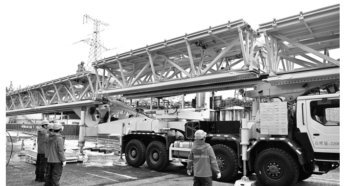
51米应急机械化桥。杭州市交通运输局供图
