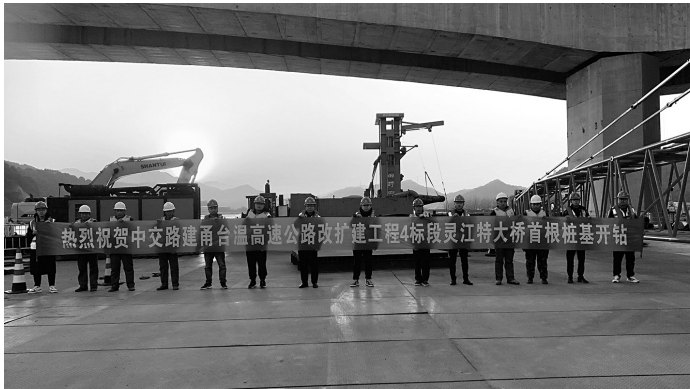
桩基开钻现场。吴添/摄
