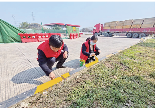
东阳 ▲为推进“美丽服务区”建设,日前,浙江交通集团诸永东阳服务区充分发挥基层党组织堡垒作用,组织人员对服务区广场路沿石进行刷漆翻新。 □姚健
