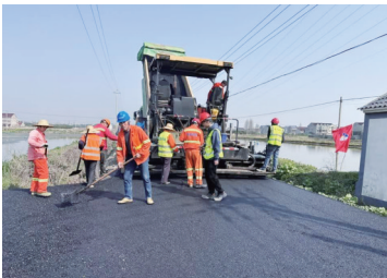
金家湾至讨渔桥路面维修工程现场。陆彦伶/摄
