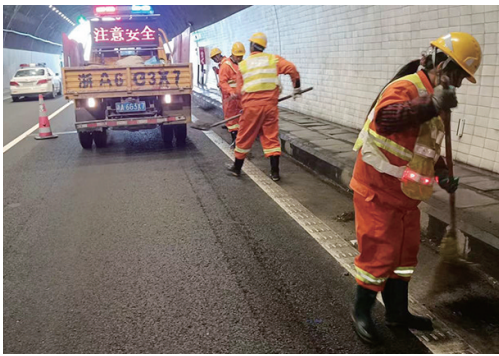
绍兴 ▲近日,浙江交通集团高速公路绍兴管理中心会同外协养护单位对所辖马岙岭隧道的内壁、路面边沟及辅助交安和机电设施进行全面清洗、靶向维护,确保清明假期正常通行。 □李洪宇
