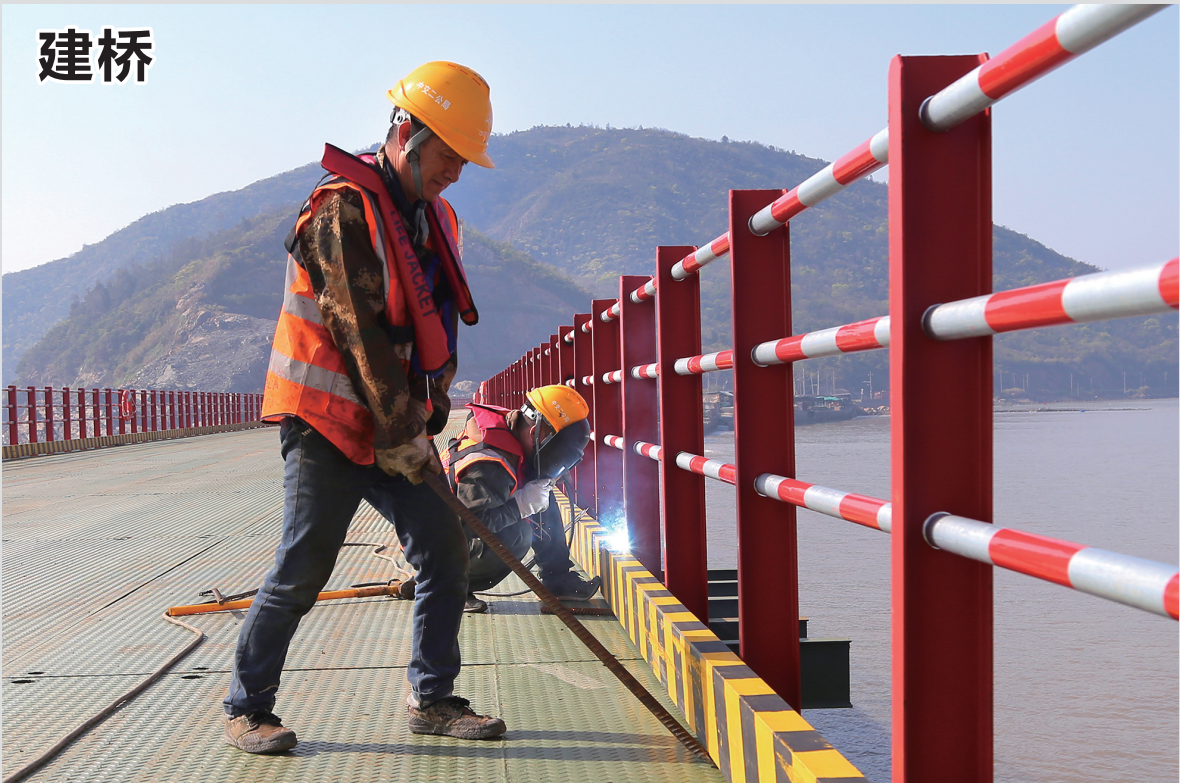
玉环 ▲4月2日,在台州1号公路玉环段西沙门大桥工程工地上,工人们正在加紧栈桥施工,力争在本月底实现1.7公里海面栈桥和干江断岙山点的相向合龙。 □吴达夫
