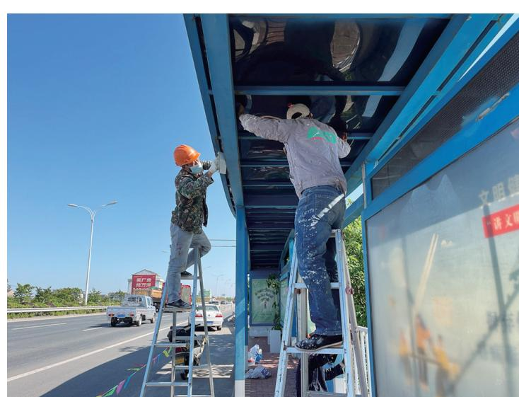
**导报讯** 近日,在台州市75省道南延椒江段附近,施工人员正有序作业,对部分公交站亭进行漆面打磨、重新上漆,并更换新的玻璃。
