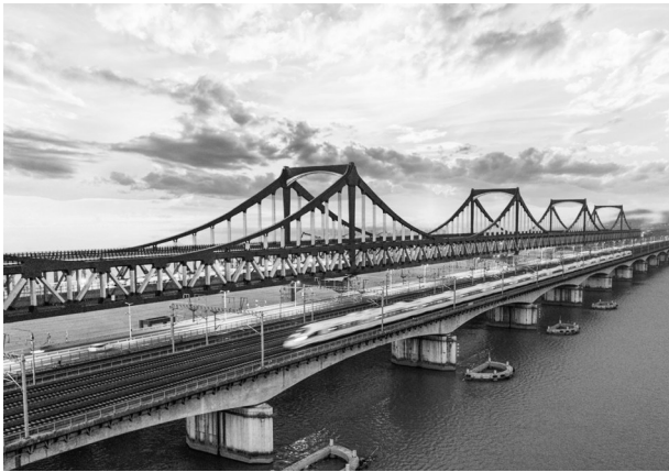
彭埠大桥一景。李清供图
