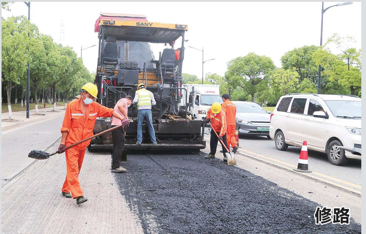
**玉环** ▲5月20日,在玉环经济开发滨海大道上,公路养护工人抓住晴朗的天气,运用摊铺机、振压机、振碎机,将原有的跳车、泡层等受损的沥青路面碎铲后,重新摊铺沥青。 □吴达夫 李金春
