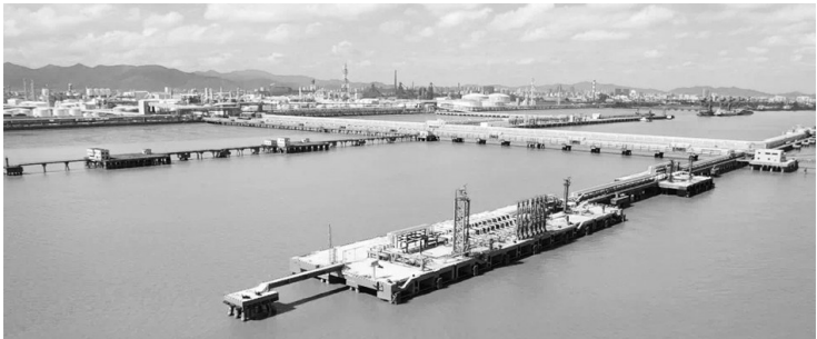
协和码头改建项目一期工程俯瞰图。郭光远提供
