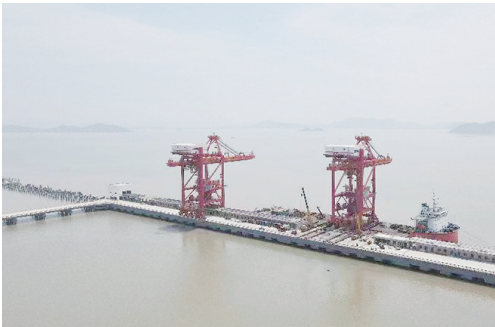
乐清 ▲6月15日下午,温州港乐清湾港区通用作业区(C区)一期工程(一阶段)2号泊位、1号栈桥顺利通过交工验收,为码头年底开港试运营奠定了坚实基础。 □陈中 周家斌
