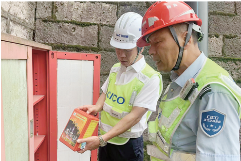
绍兴 ▲为确保辖区隧道的平安顺畅运行,近日,浙江交通集团高速公路绍兴管理中心组织相关专业职能人员,对马岙岭隧道的报警设施、安全防护设施、劳动防护物资的配备以及使用情况进行了排查。 □李洪宇
