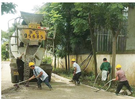
**金东** ▲近日,施工工人对金华市金东区漈宅线和杨堡-马腰孔小路破板进行凿除和修复,恢复公路平整,以延长公路的使用寿命,预防和减少交通事故的发生。
