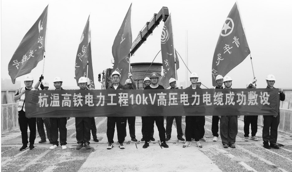
杭温铁路二期电力工程 10kV 电力电缆敷设现场。高天峰/摄
