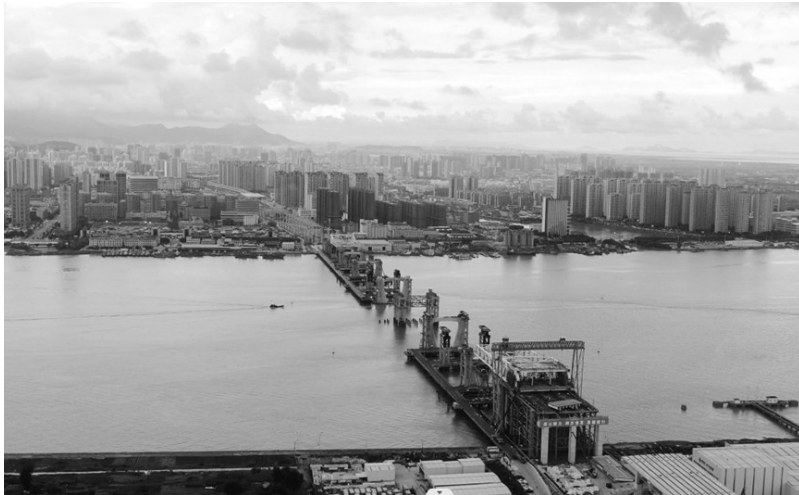
永宁大桥建设现场。田剑/摄
