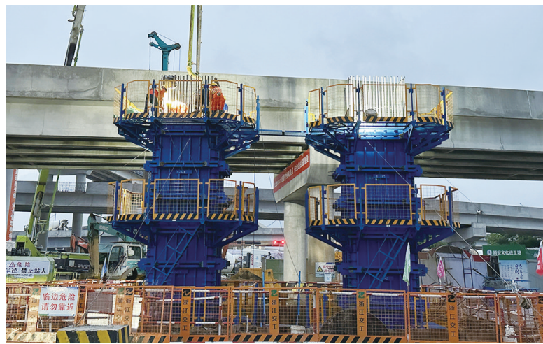
第EPC-02标段主线高架桥首根墩柱浇筑现场。韩潇/摄
