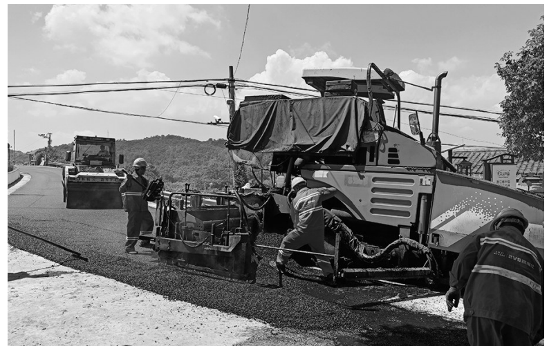
路面沥青摊铺现场。林旭/摄
