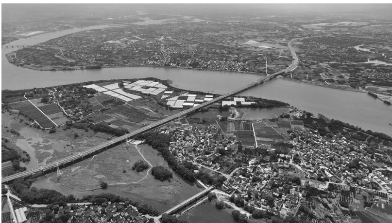
杭金衢高速衢江互通连接线俯瞰图。李惠丽/摄
