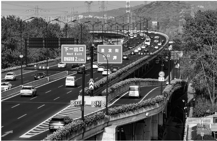
东湖高架一期(临平段)一景。王怡旻/摄
