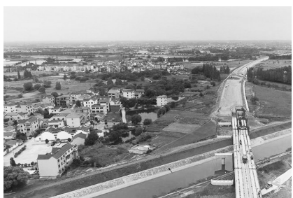
施工现场。徐正达/摄
