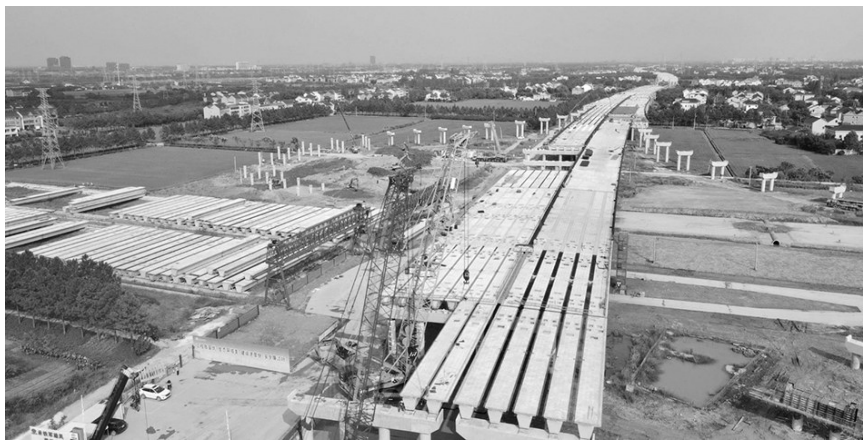
梁板架设现场。胡海英/摄
