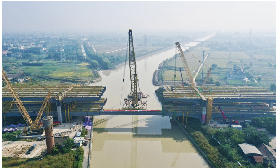
跨长山河大桥施工现场。蒋经纬/摄
