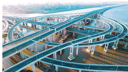
杭甬高速复线宁波段一期项目一景。李全平/摄
