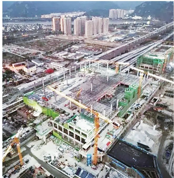
温州北站施工现场。
