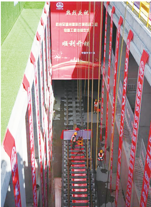
铺轨作业现场。黄宗治/摄
