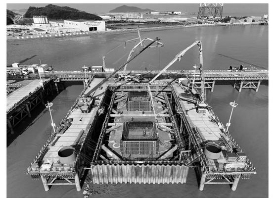
1月2日，甬舟铁路西堍门公铁两用大桥主桥2号墩承台及墩身底层混凝土浇筑完成。2号墩承台平面尺寸长39米、宽18米、高6.5米。本次承台、墩身分别浇筑混凝土2765立方米、360立方米。
