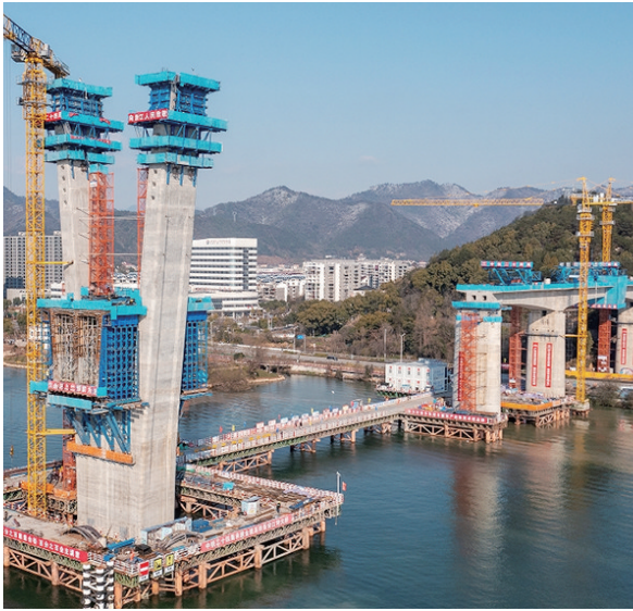
施工现场。申硕洋/供图
