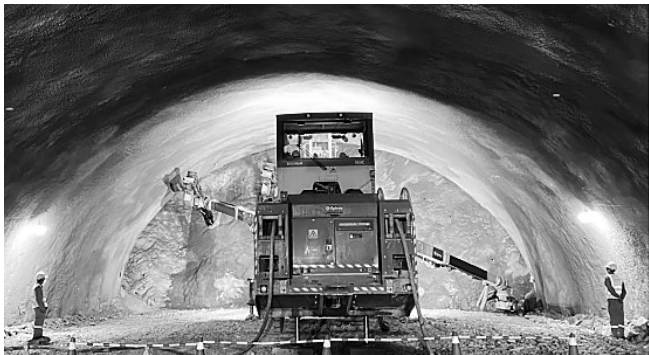
项目隧道施工现场。李嘉惠/供图
