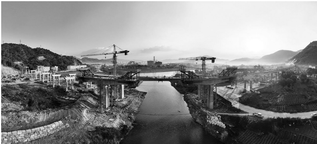
瑞苍高速建设现场。董艳哲/供图
