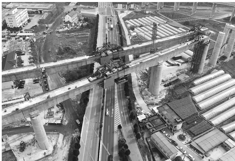
施工现场。申硕洋/供图
