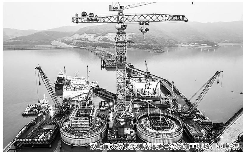
双屿门大桥佛渡侧索塔承台浇筑施工现场。姚峰 摄
