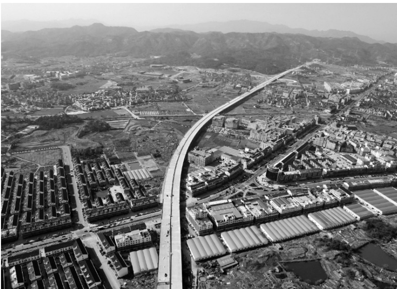
义东高速建设现场。吴作玲/供图
